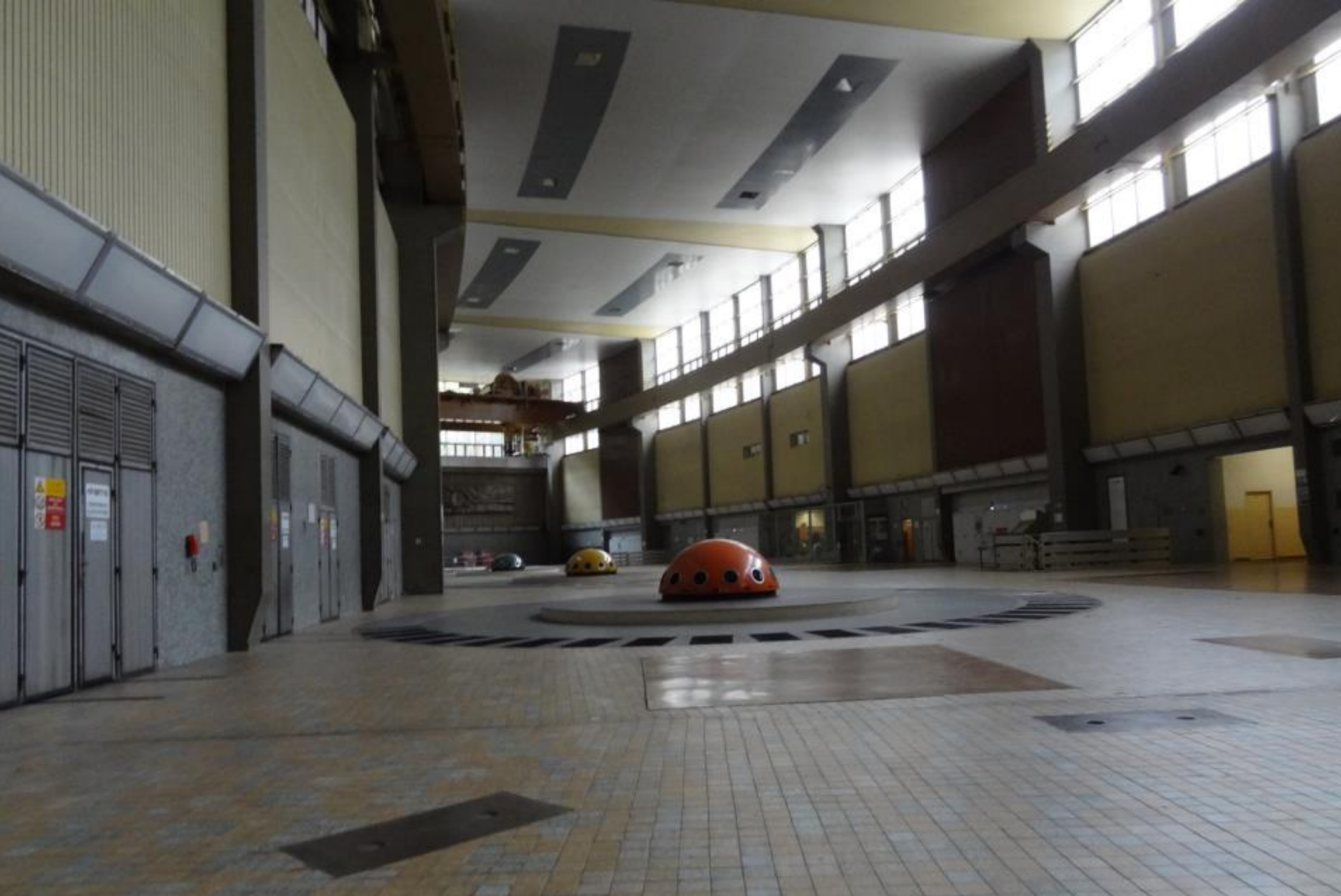
Strojovna s čtyřmi Francisovými turbínami
