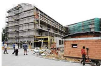
Výstavba nového Domova seniorů v Havířově.
