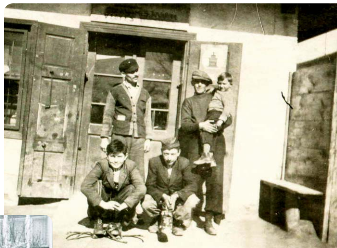
Elektrikář: Praktikant obv. montéra Slovenských elektrárén - první vážný kontakt s elektřinou (1944-5)
